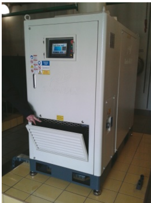
Snadná výměna filtru elektrické části.
