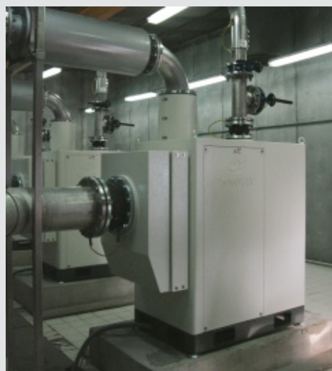
Varianta krytu s přírubou k připojení potrubí na sací straně.
