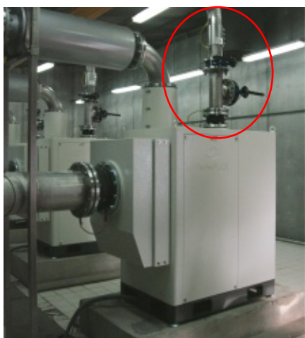
Додаткові трубопроводи, для виведення нагрітого повітря із системи охолодження двигуна назовні приміщення з перемикачем (система двох ручних дросельних клапанів) зима-літо.
