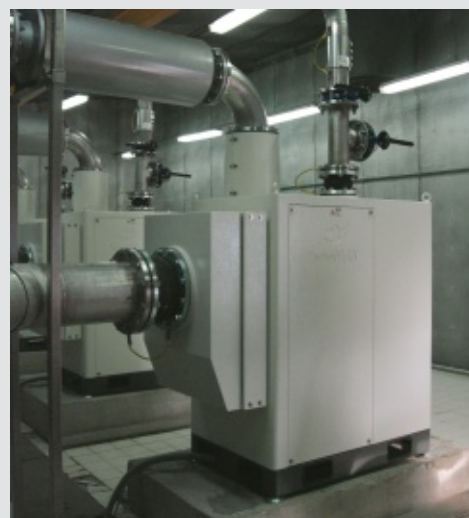
Версія корпусу з фланцем для приєднання трубопроводу зі сторони всмоктування.
