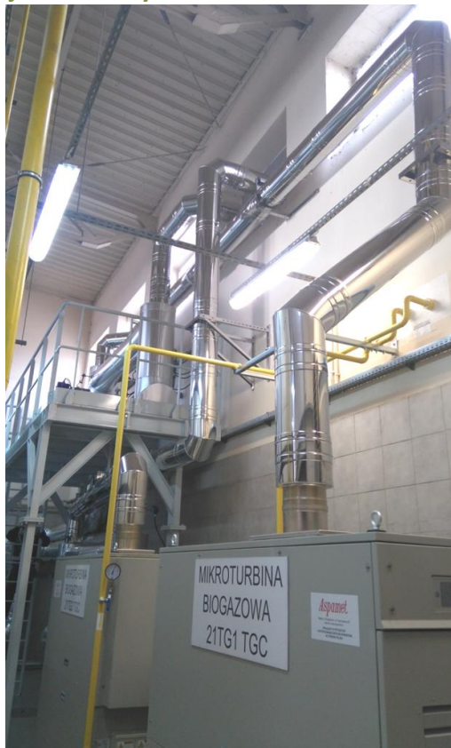
Układ spalinyowy – kominy i antresola z wymiennikami.
