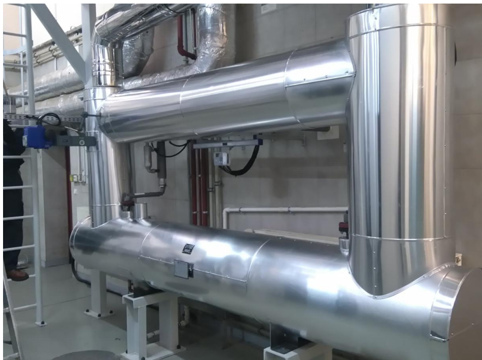
Wymiennik spaliny-woda z by-passem (obejściem) kominowym.
